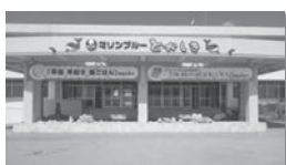
本館《事務室・研修室》
